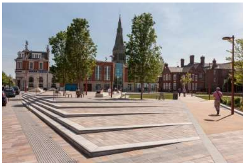
Εικόνα 1. Κεκλιμένο επίπεδο σε πλατεία στη Jubilee Square, Λέστερ, Μ.Βρετανίας, που διευκολύνει την κίνηση ΑΜΕΑ.
