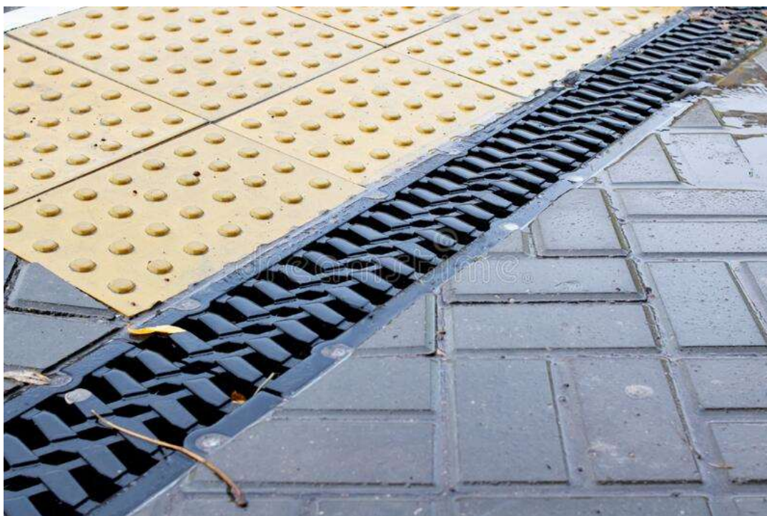
Εικόνα 36: Τοποθέτηση σχαρών στο πεζοδρόμιο (πηγή: https://es.dreamstime.com/ )
