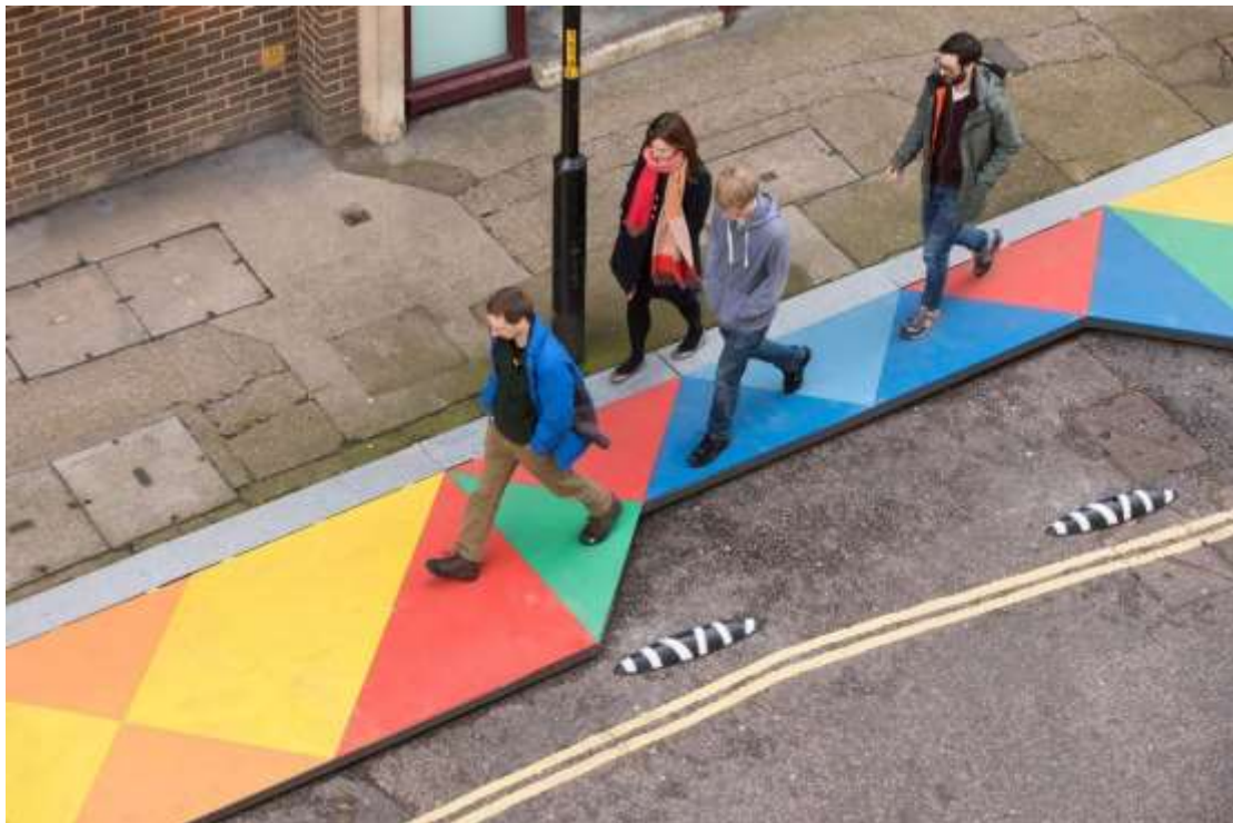
Εικόνα 23. Χαμηλού κόστους παρέμβαση επέκτασης πεζοδρομίου
