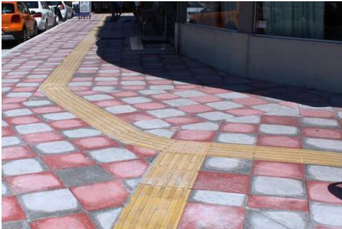
Εικόνα 35: Σταθερό, συνεχές και επιμελές αρμολόγημα (πηγή: https://www.stonisi.gr/post/3211/oloklhrwthkan-oi-ergasies-sto-telwneio-mylthnhs-pics )
