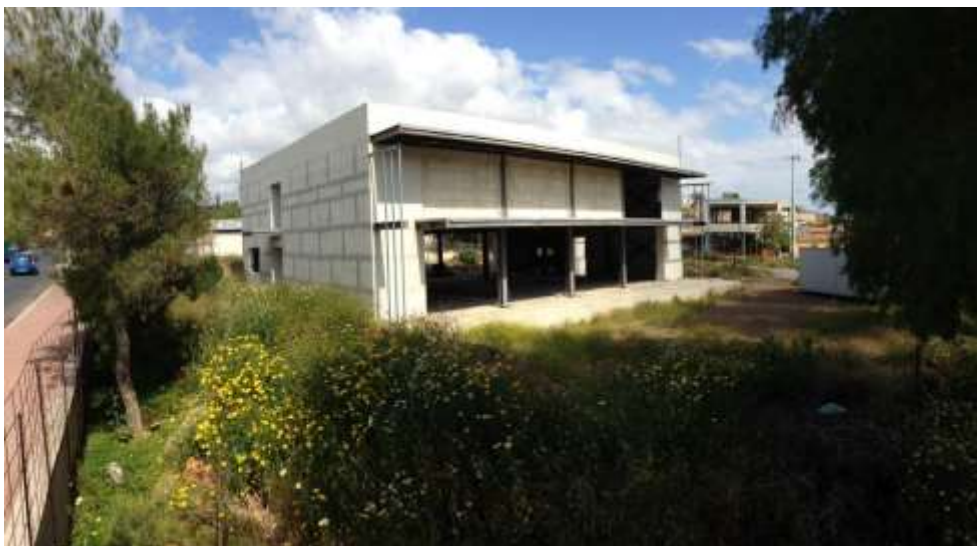
Εικόνα 3: Απόψη του ήδη κατασκευασμένου κτιρίου
