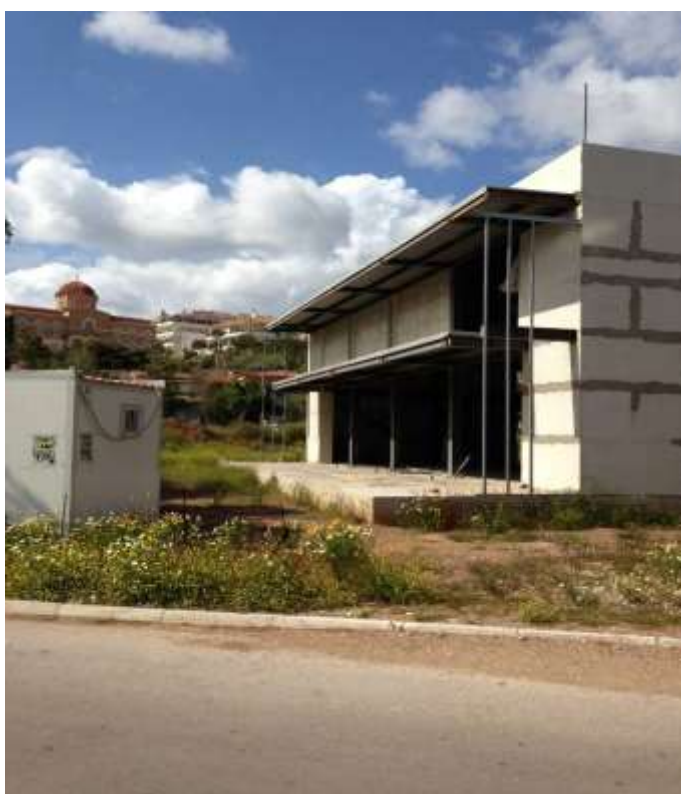
Εικόνα 4: Απόψη του ήδη κατασκευασμένου κτιρίου
