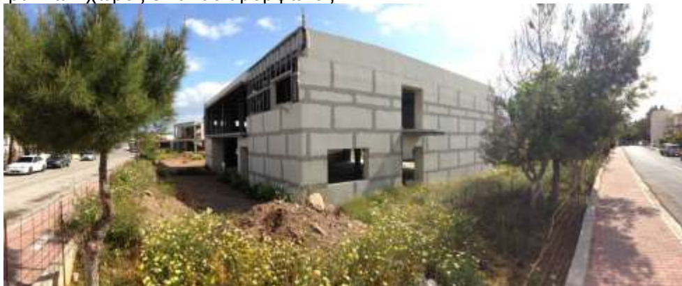
Εικόνα 2: Απόψη του ήδη κατασκευασμένου κτιρίου
